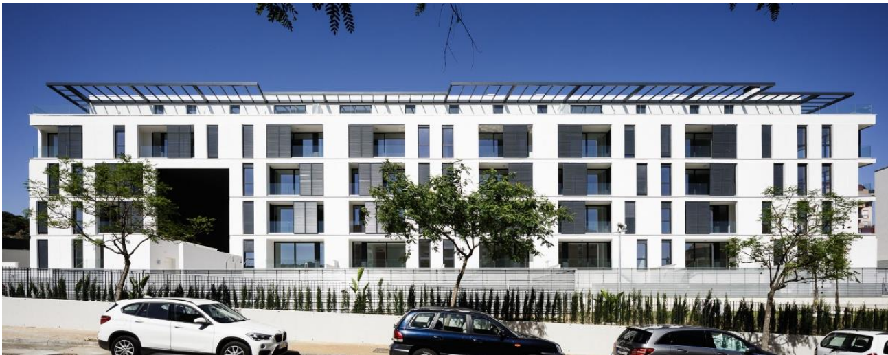
Conjunto Residencial en Huerta Nueva, Málaga.
