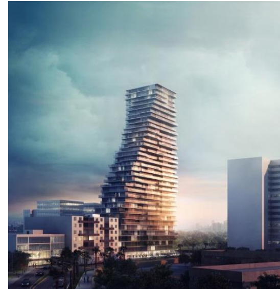
Torre residencial, Lima (Perú)
