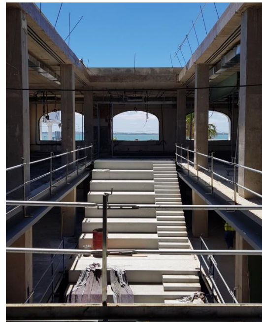
Sede corporativa Torrot, Cádiz.
